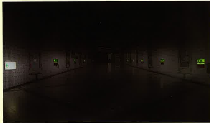
大阪・梅田地下街「ホワイティうめだ」(1日あたりの平均通行者数：約60万人)に設置されている高輝度蓄光式誘導標識「しるべにすと」と停電時のイメージ画像。
