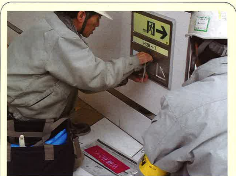
広告表示面の設置作業
