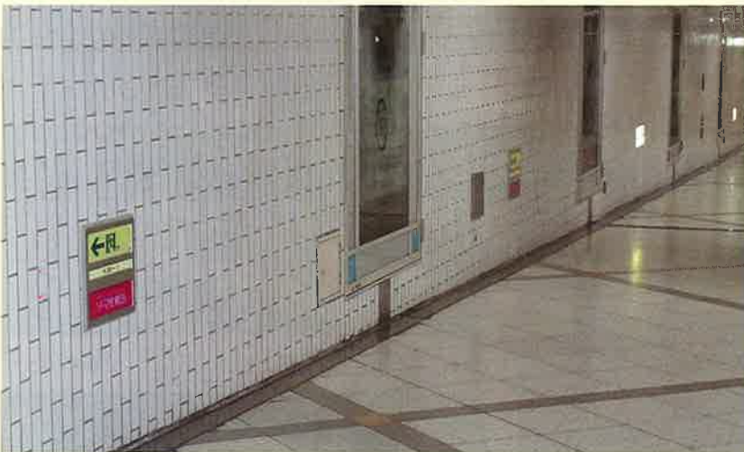
「しるべにすと」が設置されている高さは、高輝度蓄光式誘導標識が床面から1m以内となっている（平成22年4月9日付総務省消防庁「蓄光式誘導標識等に係る運用について」の技術基準に準拠）。
