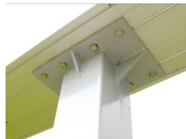
■ 柱と内照型サインのジョイント部
