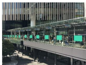
No. 2 広場デッキシート
