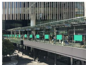
No. 2 広場デッキシート
