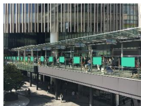
No. 2 広場デッキシート
