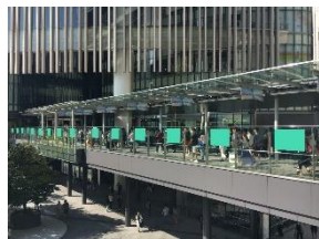
No. 2 広場デッキシート
